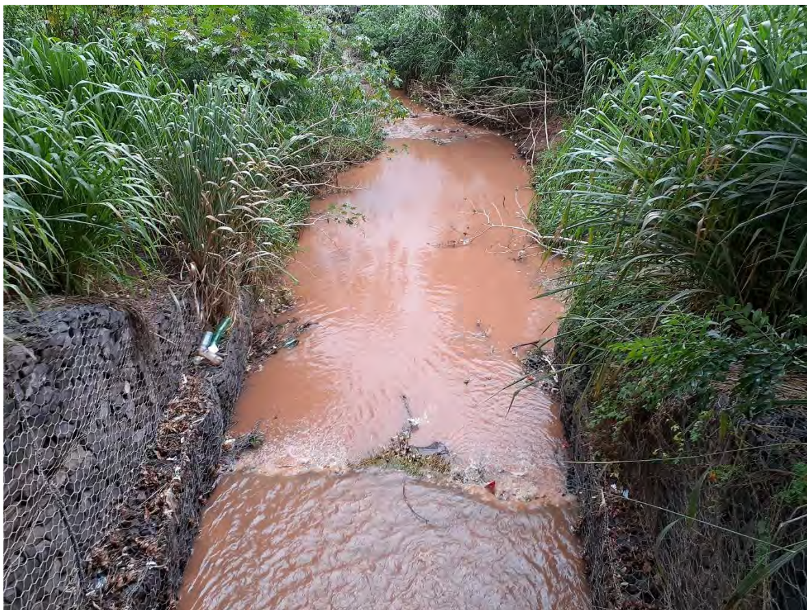
Imagem do Córrego Alheiro a montante, continuação da canalização a jusante, 07/02/2020.
