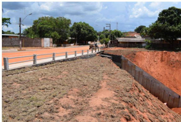
Foto 12 – Vista interna da obra Av. São Paulo.
