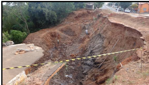
Foto 10 – Erosão Av. São Paulo.
