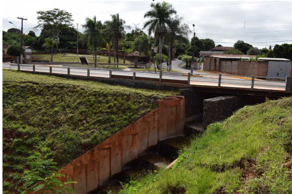
Foto 13 – Vista novo dissipador Av. Sã Paulo.
