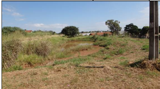
Foto 29 - Caixa de contenção – Nova Parapuã.
