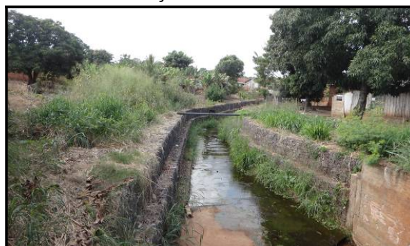
Foto 16 – Canalização à Montante Av. S. Paulo.
