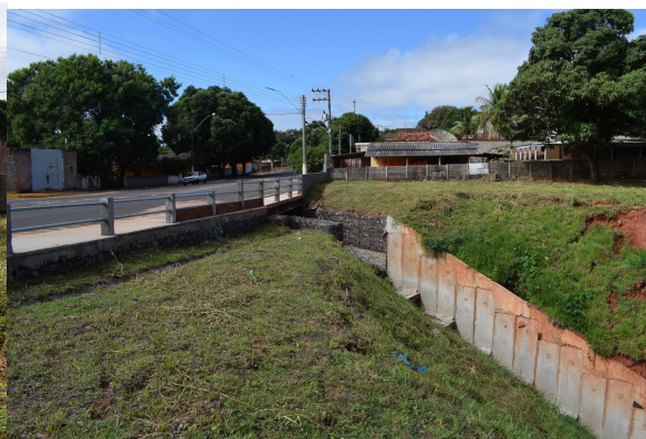
Foto 14 – Obra finalizada Av. S. Paulo.
